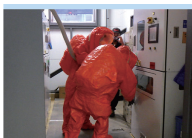
耐ガス・耐薬品保護具を着用しての作業
